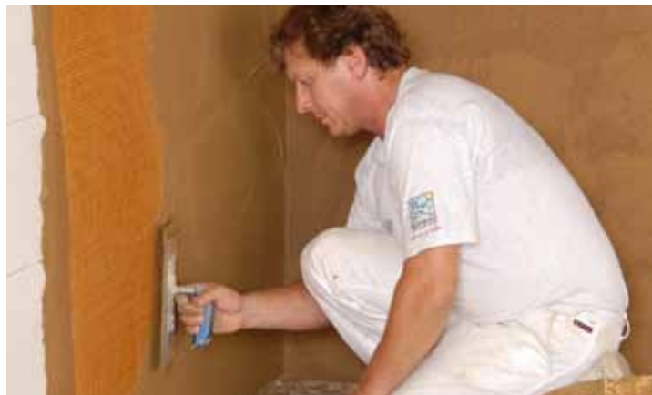
Inserimento di fibre di vetro in calce naturale, un metodo semplice e rapido
